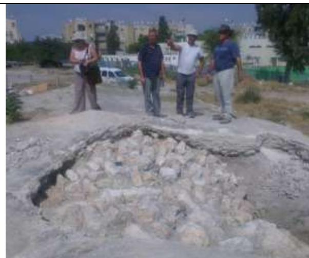
בקרה על מבנה הקמרון לפני מילוי וטיח
