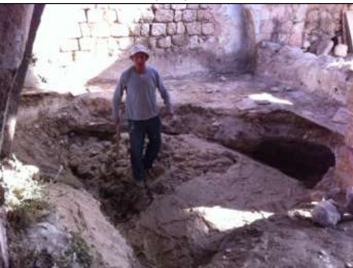
גמר שחזור הקמרון לפני מילוי מפלס הרצפה
