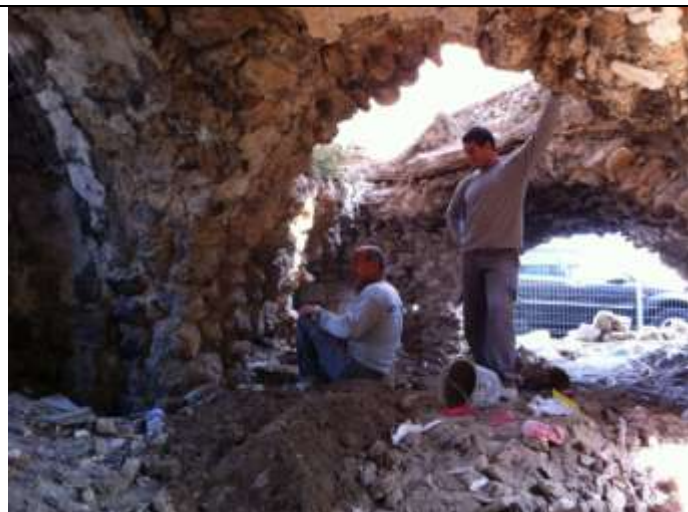
ייצוב אומנות לפני תחילת שחזור הקמרון הצפוני-מערבי
