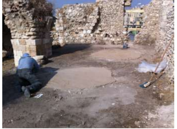
שיקום רצפה בקומה העליונה לאחר ניקוי שפכים ושחזור
