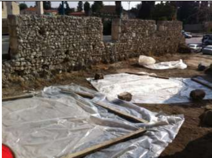
הנחת יריעות פוליאתילן למניעת ייבוש מהיר של הטיח
